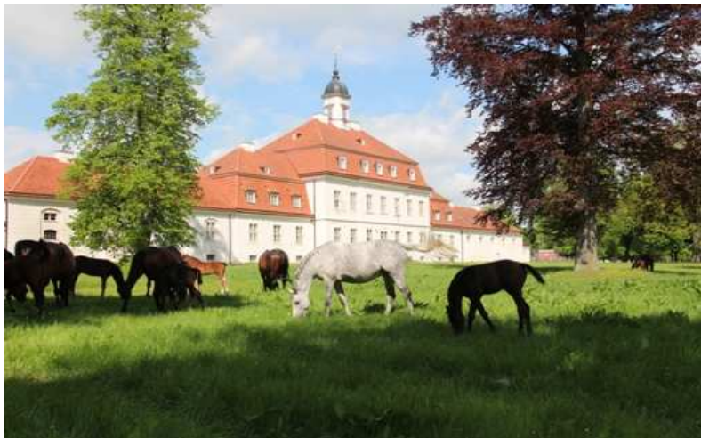
Abbildung 2: Rekonstruiertes Landstallmeisterhaus im Hauptgestüt 2013.
